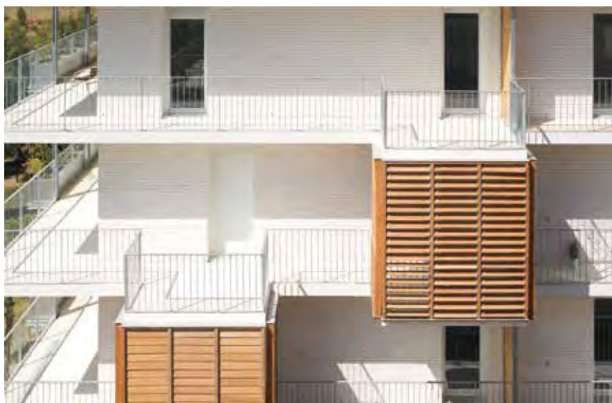
La double exposition des logements permet une ventilation naturelle. Mais les usagers oublient parfois d'éteindre le système de climatisation quand les fenêtres sont ouvertes...
