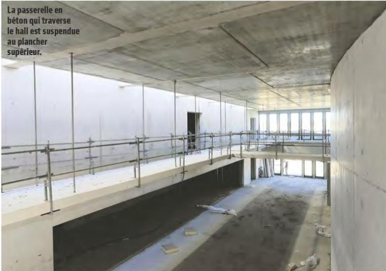
Le mur à double courbure de 7,20 m de haut a été coulé sans reprise de bétonnage sur la hauteur.
